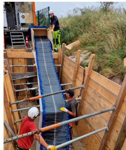
Die kompakten Transportmaße des Alphaliners begünstigten die Rohrinstallations im UNESCO-Weltnaturerbe
